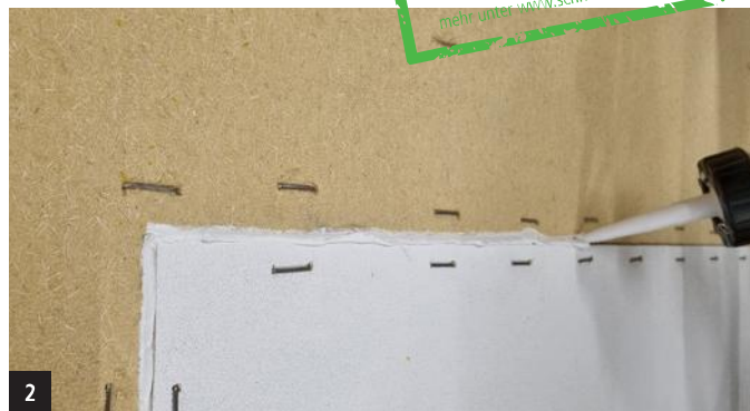
2 Fugen in Fassadenebene mit FDM WALL verschließen
