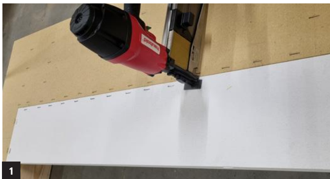
1 STURZBLENDE umlaufend auf halbe Ständer-/ Riegelbreite klammern
