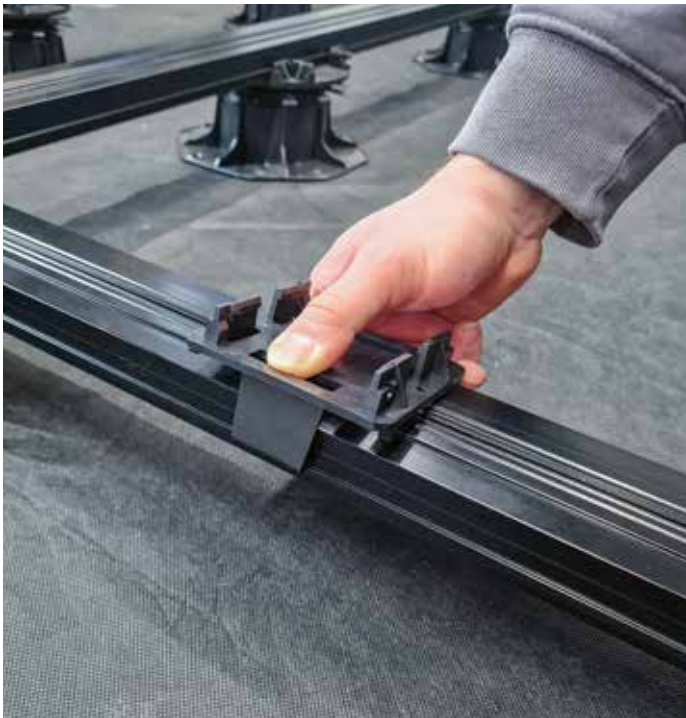
KL-Kreuzverbinder auf die ausgerichtete Konterlattung einklicken
