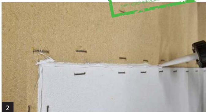
2 Fugen in Fassadenebene mit FDM WALL verschließen
